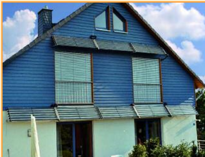
Montaggio su facciata di 8 moduli TUBO, Germania
