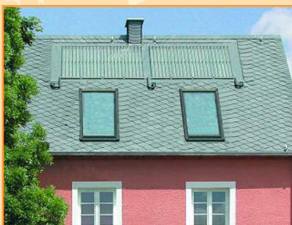
Moduli TUBO a incasso praticamente invisibili, Germania
