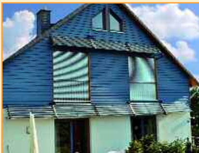
Montaggio su facciata di 8 moduli TUBO, Germania
